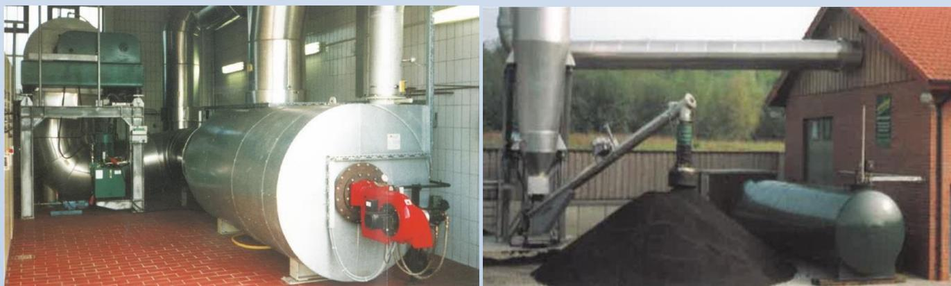
**Установка CENTRIDRY® на КОС Хидденхаузен (Германия)****Производительность 15 м<sup>3</sup>/ч, исходная влажность 96%; выход – 70% СВ.**
